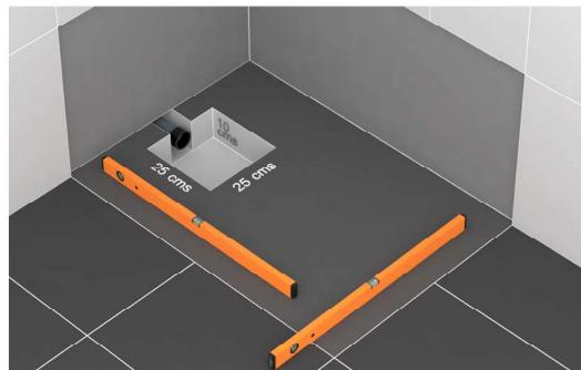
Preparar una base lisa de mortero perfectamente nivelada y seca, dejando un hueco según croquis para poder alojar y conectar la válvula de desagüe con la bajante de la obra.
